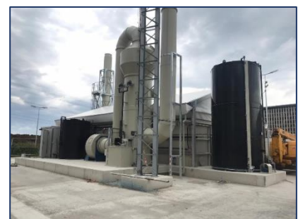
Configurations d'utilisation d'un bio filtre en association avec un laveur
